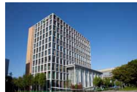
H26.11 金沢駅西に北國本店ビル を建設
